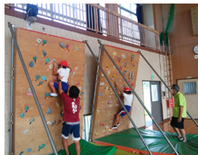
宇和島市立畑地小学校ボルダリング壁設置 体育の教室
