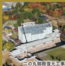
二の丸御殿復元工事
