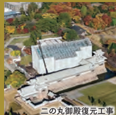
二の丸御殿復元工事
