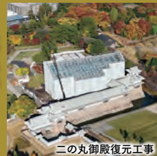
二の丸御殿復元工事
