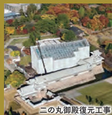
二の丸御殿復元工事
