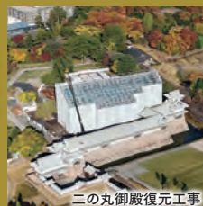
二の丸御殿復元工事
