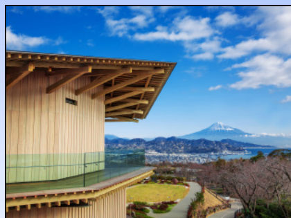
日本平夢テラス (静岡市)
