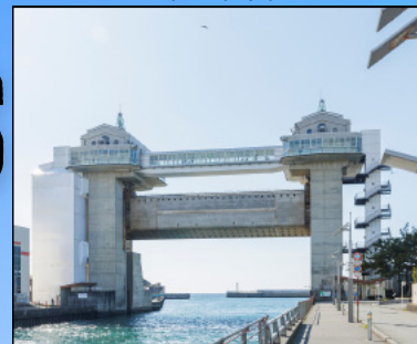
沼津港大型展望すいもん 「びゅうお」 (沼津市)
