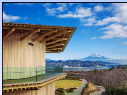
日本平夢テラス (静岡市)
