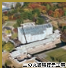
二の丸御殿復元工事
