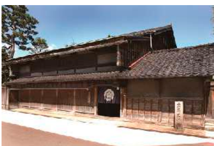
国指定重要文化財喜多家住宅 (野々市市)
