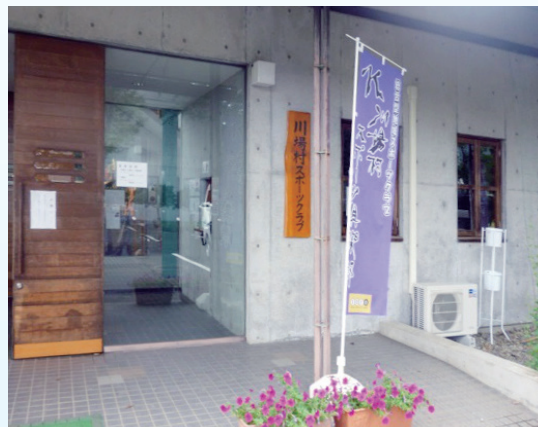
川場村武道館内のクラブハウス
