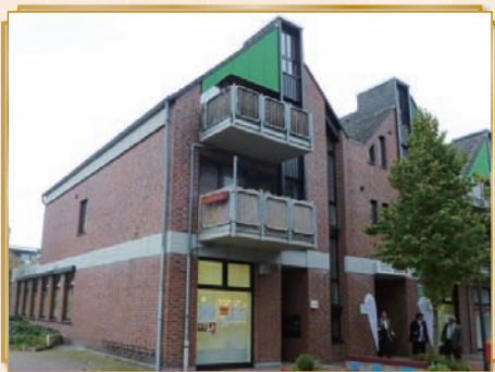
コルシエンプロイヒニア世代スポーツクラブの建物
